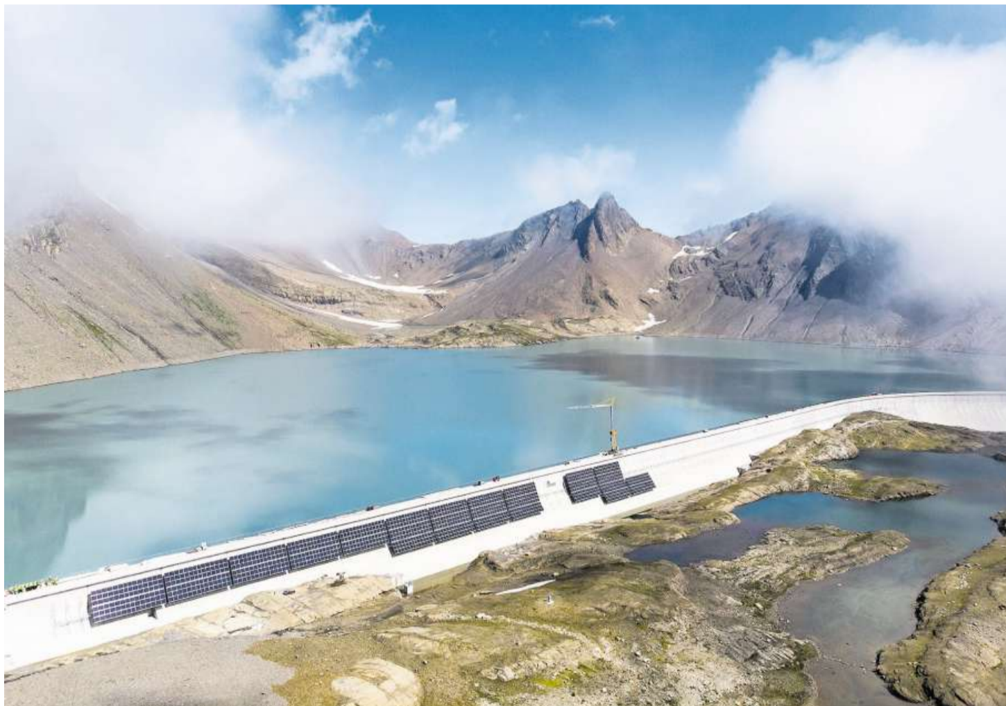
An der Muttsee-Staumauer im Glarnerland werden 4872 Fotovoltaikmodule angebracht. Bild: Gian Ehrenzeller/Keystone (Linthal, 19. August 2021)
