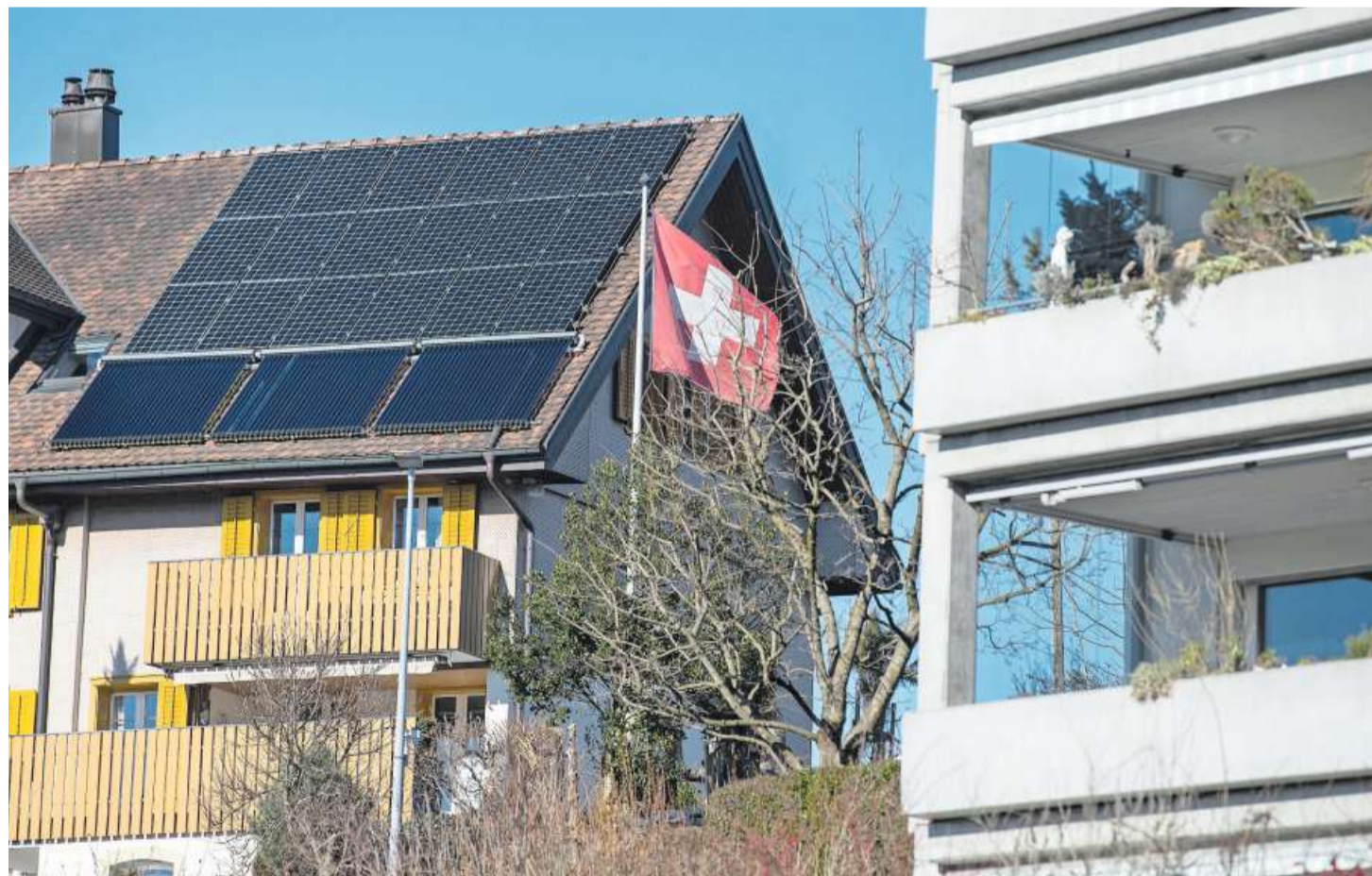
Der Luzerner Kantonsrat will die Installation von Solaranlagen auf privaten Liegenschaften besser fördern. Bild: Boris Bürgisser (9. Februar 2022)
