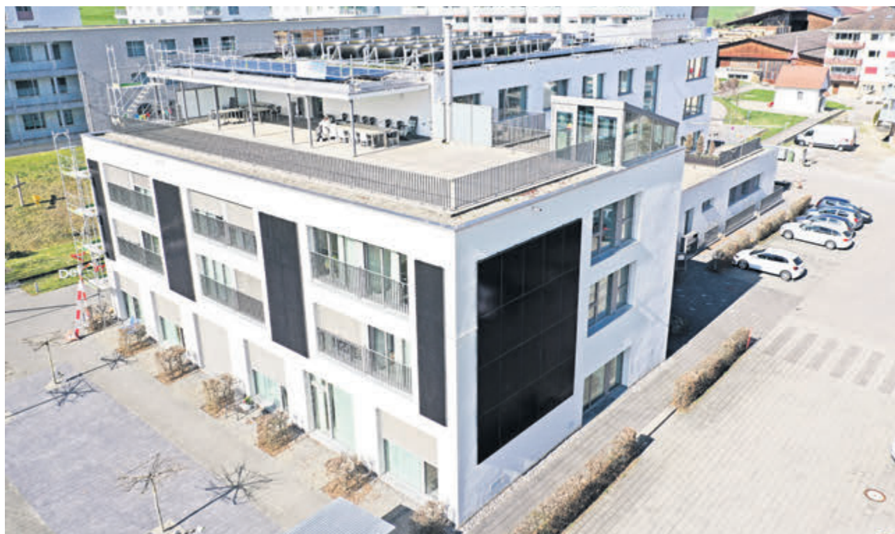
Auch einzelne Teile der Fassade wurden beim Zentrum Eymatt mit Solarmodulen bestückt.
