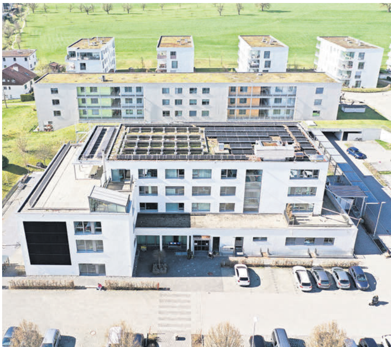
Beim Zentrum Eymatt realisierte die Genossenschaft e-nottwil eine weitere Photovoltaikanlage.
