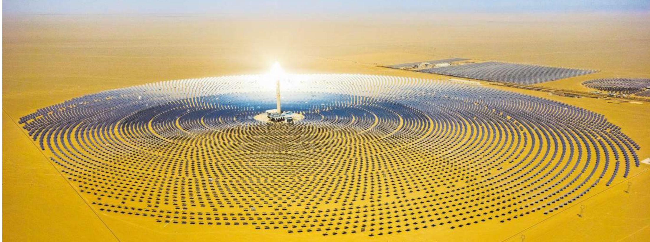
Eine neuartige thermodynamische Solaranlage in Dunhuang City in China mit einem Solarturm im Zentrum. Die 100-Megawatt-Anlage speichert die Tageshitze in einer Trägerflüssigkeit.
